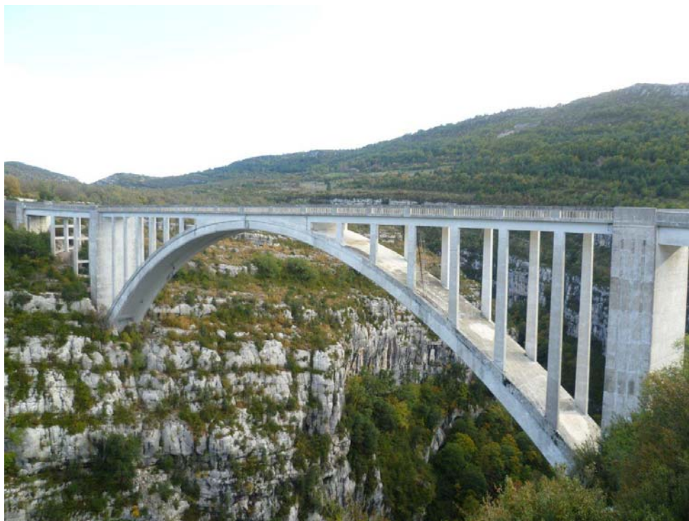
Pont de Chaulière -nejvyšší most v Evropě
